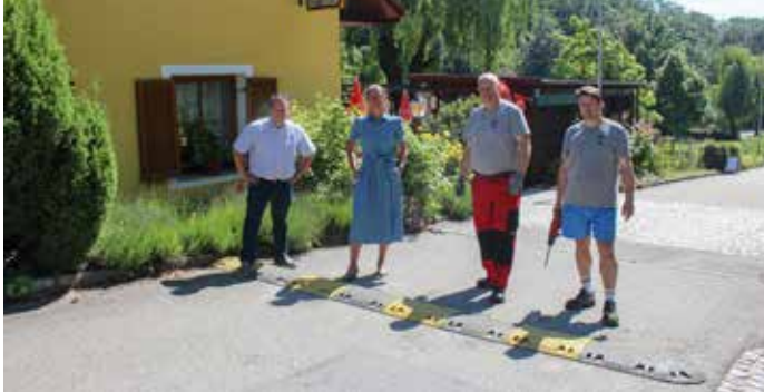
Zur Sicherheit der Badegäste wurde vor Karin´s Gaststube ein zusätzlicher Schweller zur Geschwindigkeitsreduzierung installiert.
