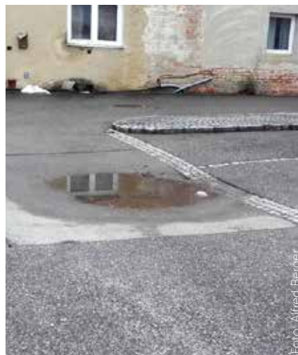
Absenkung am Hermannschacht: Nach Regenfall sieht man die Problemstellen
