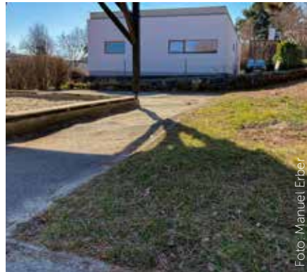
Der Asphalt am Kindergartenareal wird noch in diesem Jahr saniert.
