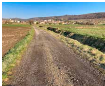
Flötzersteig nach der Sanierung
